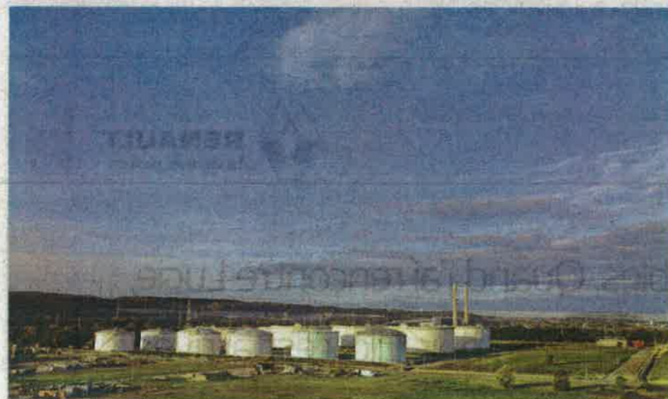
Des panneaux solaires seront déployés en plusieurs endroits du dépôt de carburant, à la place des anciennes installations de raffinage.
