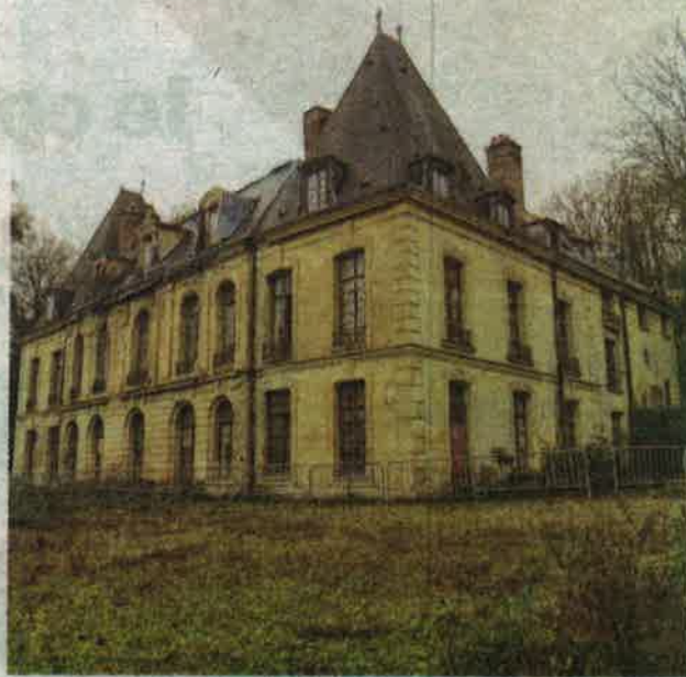
Le château d'Issou est très endommagé. (Archives).
