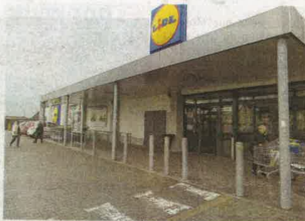
Lidl prévoit de fermer son magasin d'Issou pour aller s'installer à Guitrancourt.
